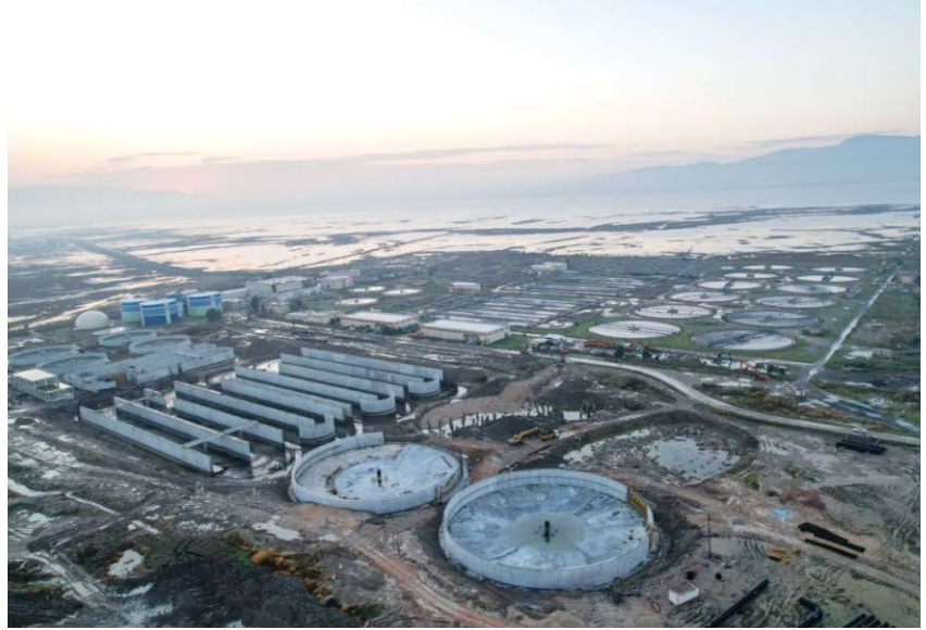
Çiğli Atıksu Arıtma Tesisi
